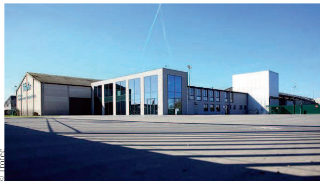
Siège de l'entreprise Trotec à Veurne (Belgique).
